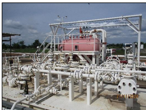
ภาพถ่ายที่ 2-11 ระบบวาล์วบริเวณหัวบ่อ Christmas Tree และ Manifold
