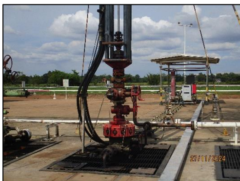
ภาพถ่ายที่ 2-11 ระบบวาล์วบริเวณหัวบ่อ Christmas Tree และ Manifold
