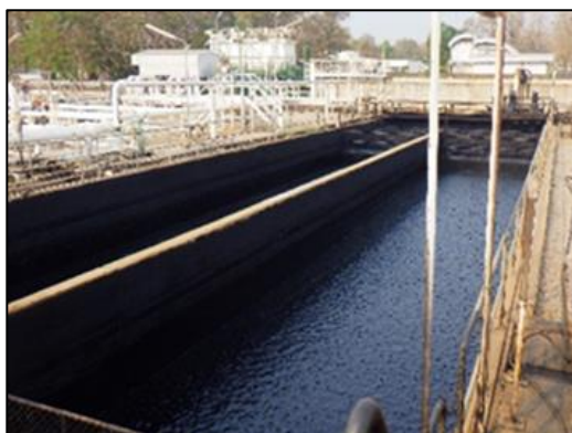
ภาพถ่ายที่ 2-7 API Separator สถานีผลิตลานกระบือ
