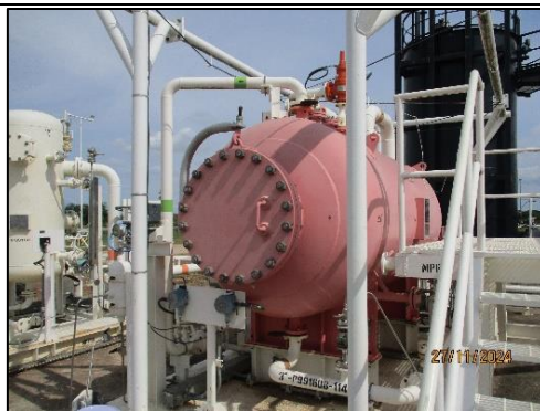
ภาพถ่ายที่ 2-10 เครื่องแยกสถานะของเหลว-ก๊าซ (Production Separator)
