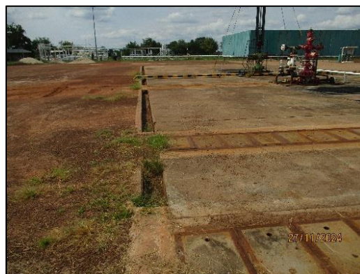
ภาพถ่ายที่ 2-4 รางระบายคอนกรีต
